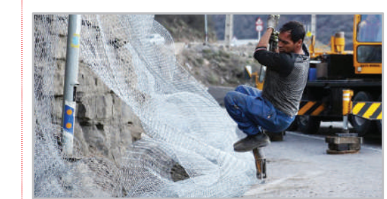
عملیات ایمن‌سازی جاده چالوس
